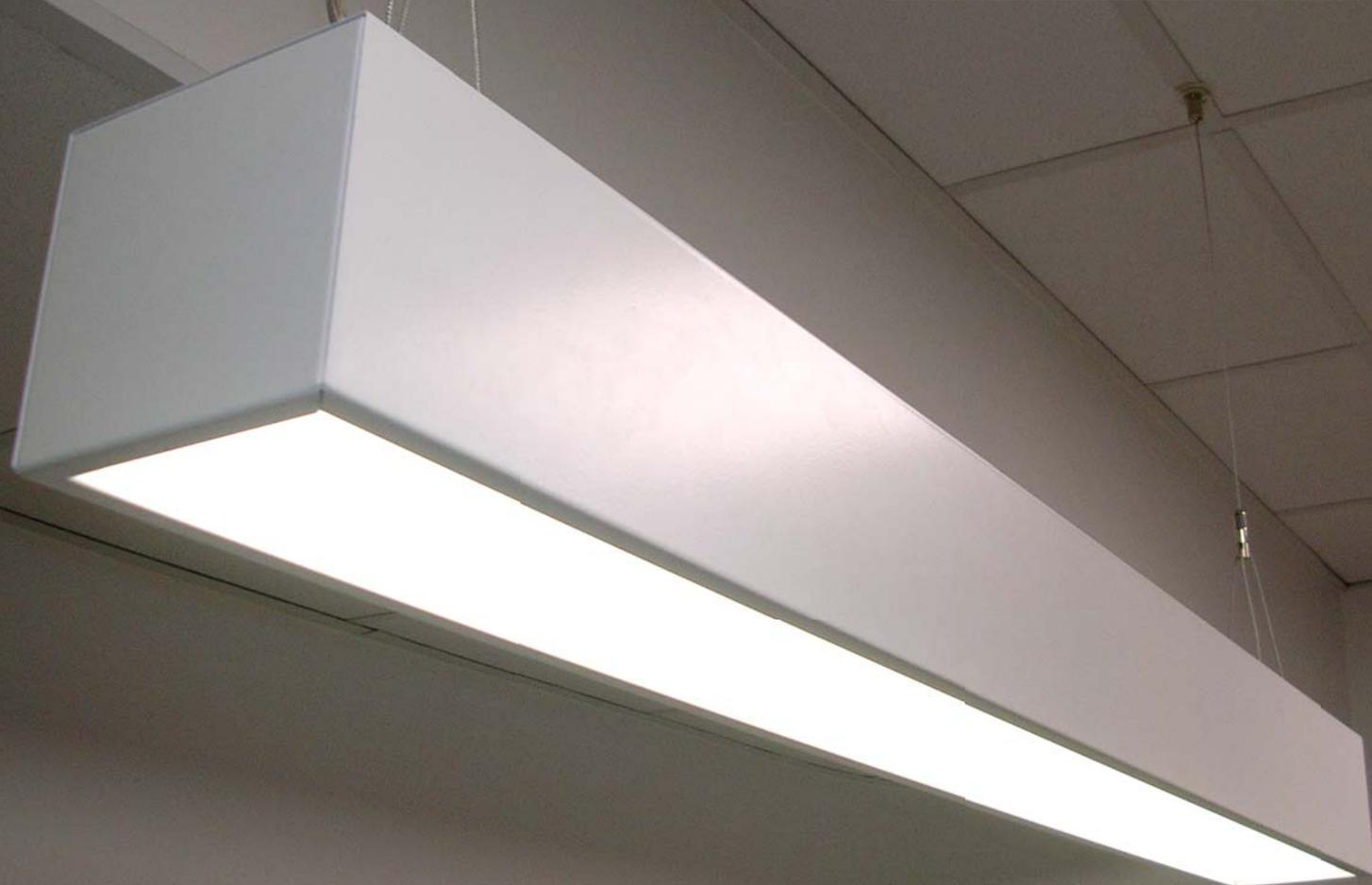
Luminaire suspendu équipé de platines LED mid-power
